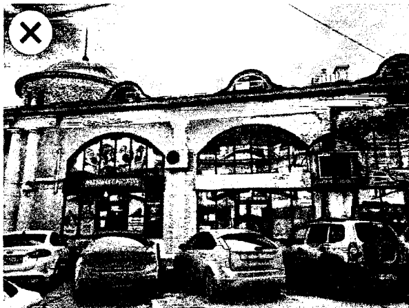
Кондиционеры на заднем фасаде здания ОКН, представляющего высокую архитектурную ценность, ухудшают его облик.
