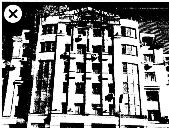
Кондиционеры на фасаде жилого дома размещены хаотично и не замаскированы экранами.
